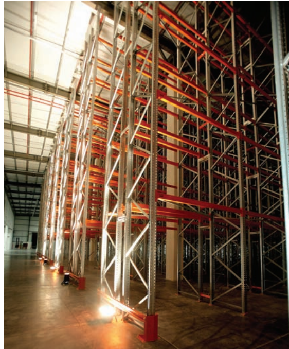
מערכת מסוג "Pallet Racking"
