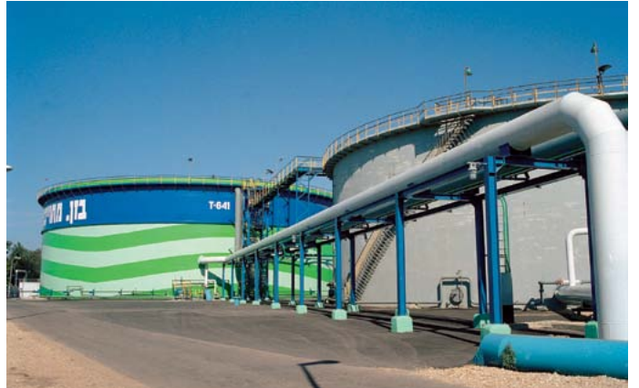
מיכל סערה הקולט מי גשם בימי שיא. משאבות מעבירות את המים למיכל, כדי למנוע שכך לנחל הקישון
